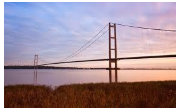
Humber Bridge, N. Lincs, UK
